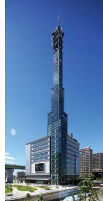
中京テレビ放送本社ビル
