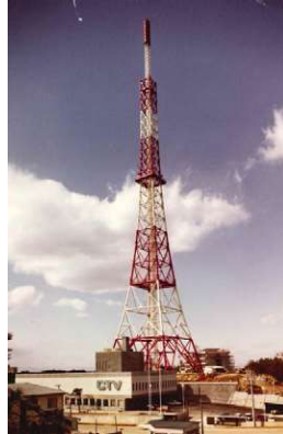
中京テレビ放送旧本社ビル
